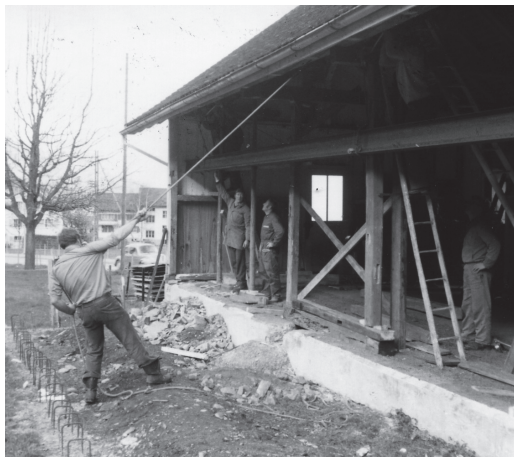
Neubau des Schiessstandes
